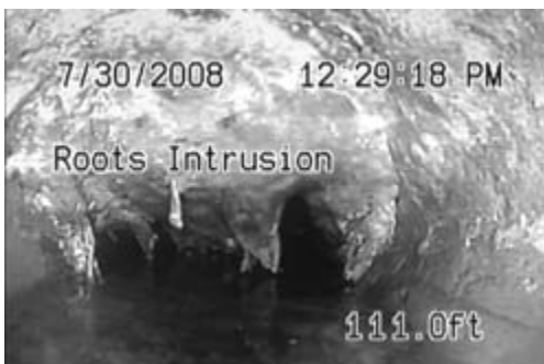
Figuur 25 – Scherm met weergave van diatekst, tijd en afstand (afstand gemeten vanaf systeemnulpunt)
