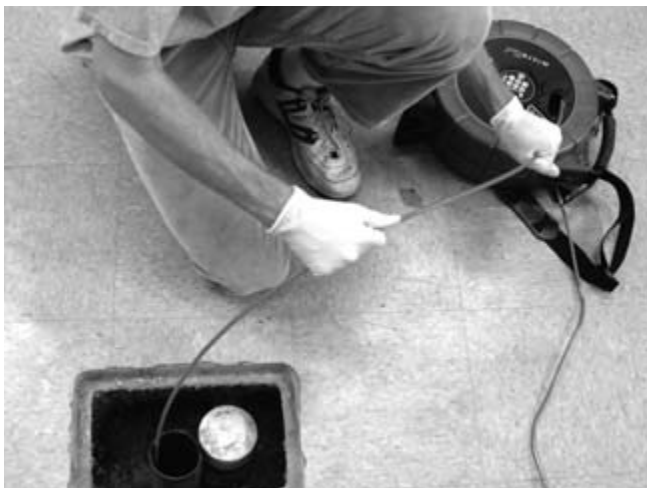
Figuur 28 – Juiste techniek om de duwkabel terug in de haspel te duwen
